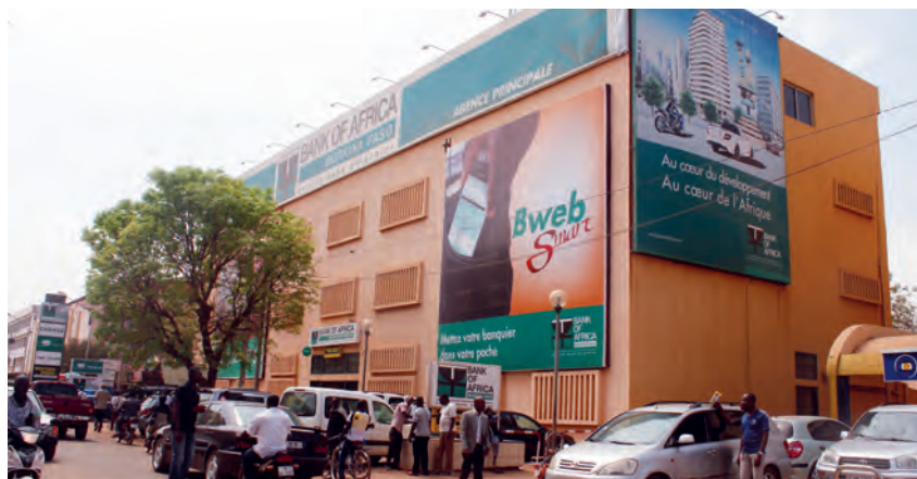
L'Agence Centrale à Ouagadougou. The Central Branch, in Ouagadougou.
