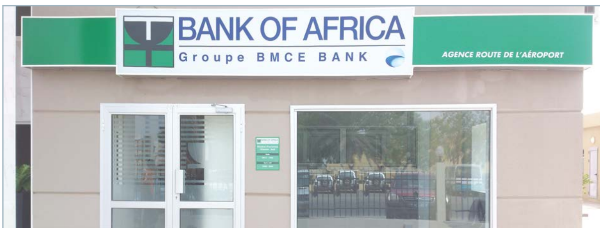
L'Agence route de l'Aéroport, à Djibouti
